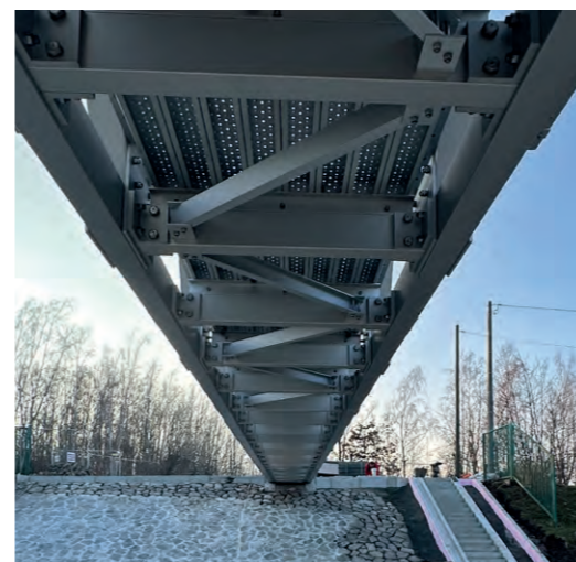
Fachwerkverstrebung des Bodens für mehr Stabilität
