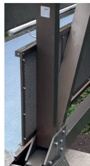
Lochblech als Füllung Edelstahl-Handlauf für mehr Sicherheit
