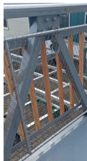
Geländerfüllung mit Edelstahldrahtnetz
