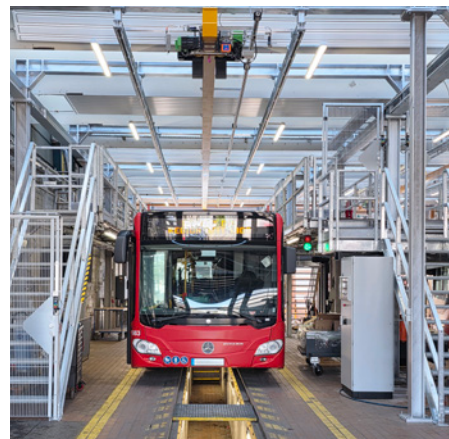
Frontansicht: Parallele gesicherte Aufgänge. Kran mit Führungsschiene
