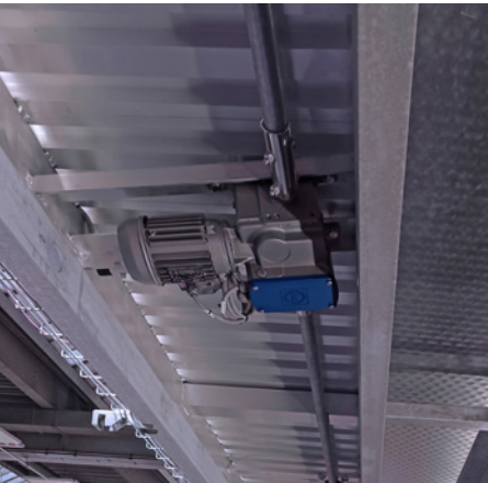
Getriebemotor EWA XX oder EZW 64.xx mit integriertem Endschaftersystem für den Plattformausschub
