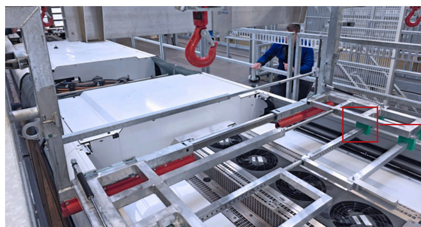
Damit der Kran inklusive Traverse und Krangut die Absturzsicherung durchfahren kann, wird die Absturzsicherung nach unten gekippt
