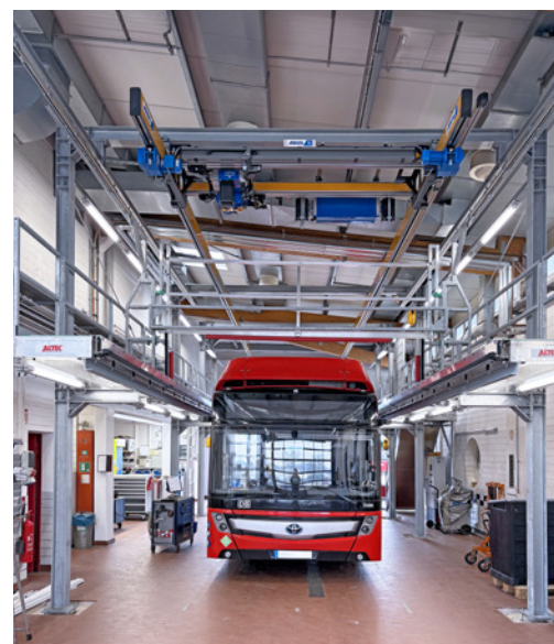
Frontansicht der Dacharbeitsbühne
