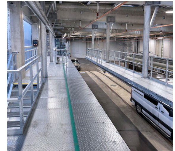
Podestausschub aufgrund der Tragfähigkeit aus verzinktem Stahltränenblech, Podestausschub 400 mm bis zu einem Spaltmaß „0“
